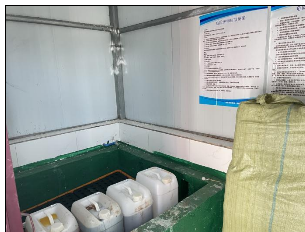
图 3-9 危废暂存间内部
