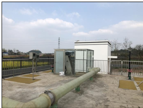
图 3-3 封闭式格栅间
