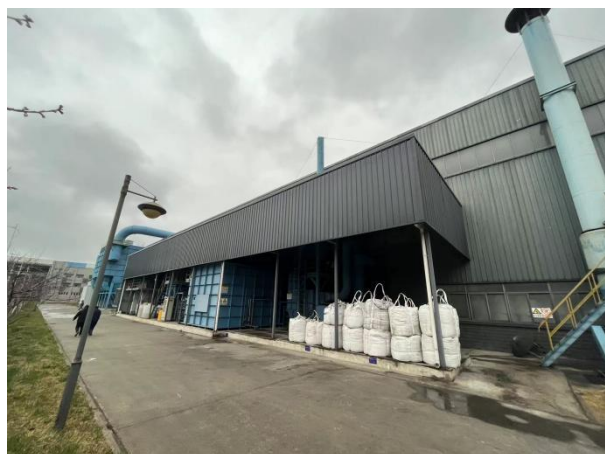
图 3-3 湿法再生生产线 15m 高排气筒（DA005）
