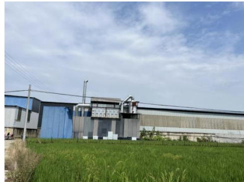
图 3-4：3#车间中央布袋除尘器 15m 高排气筒（DA001）
